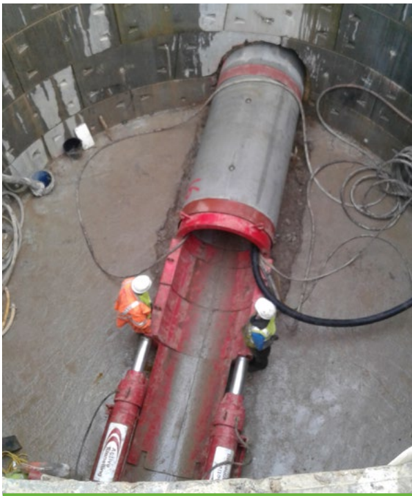
Oibreacha ar Líonra Séarachais Bhaile Ros Comáin
