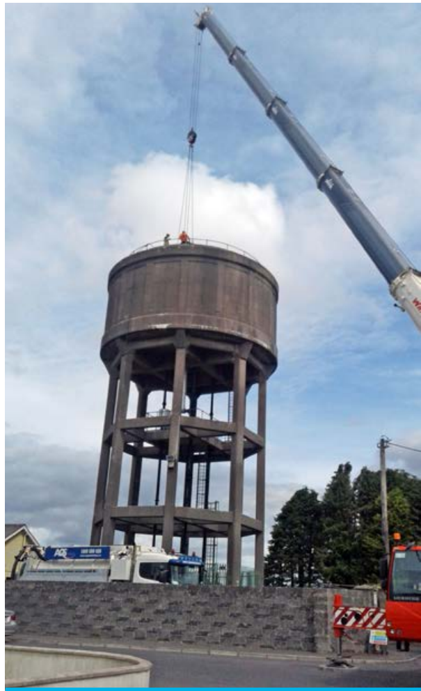
Oibreacha Glanta ag Túr Uisce an Chaisleáin Riabhaigh.
